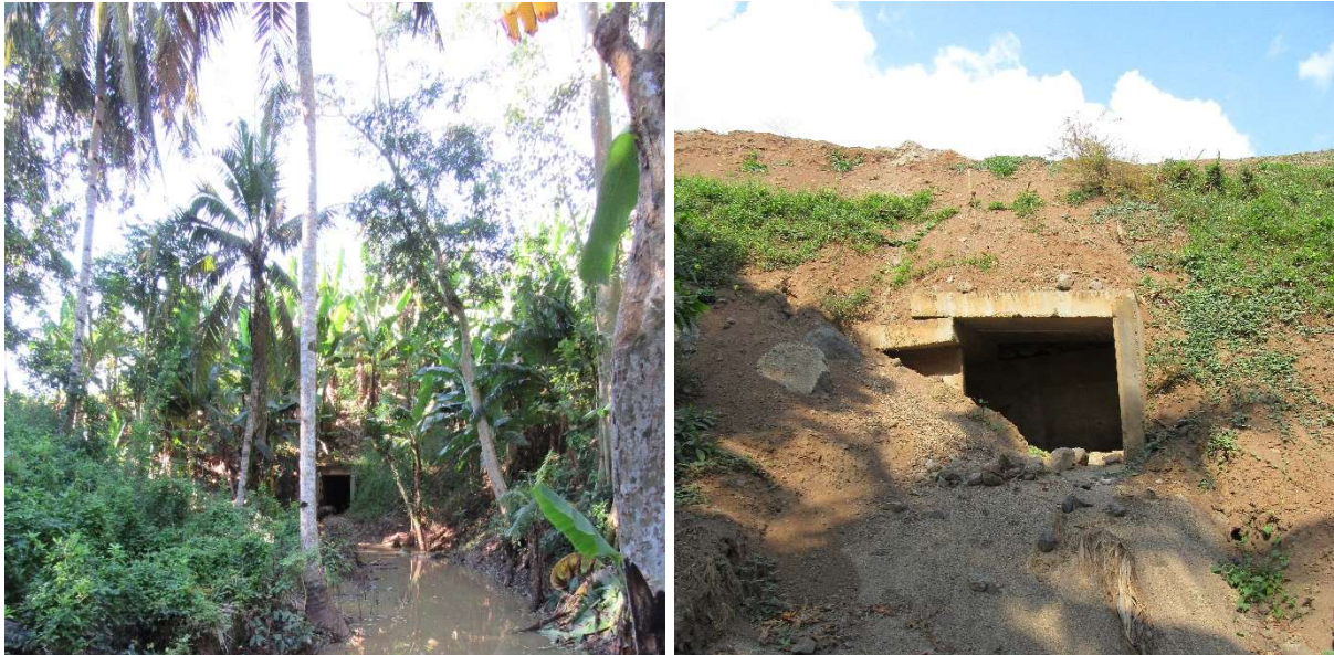
Vue des 2 extrémités du dalot existant
